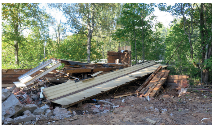
Purkutyöt kyllä sujuvat kunnassakin. Kuvassa ent. myllärin asuinrakennus
